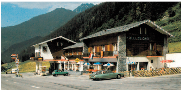
Le premier agrandissement de l'hôtel du Crêt en 1967
